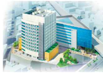
医学部附属満口病院新病院 (建設中)
