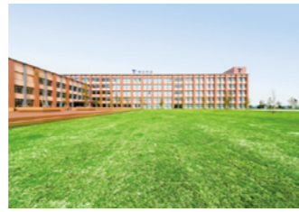
福岡医療技術学部新校舎 (2013年度竣工)
