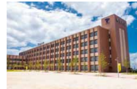
福岡医療技術学部新校舎(平成25年度竣工)
