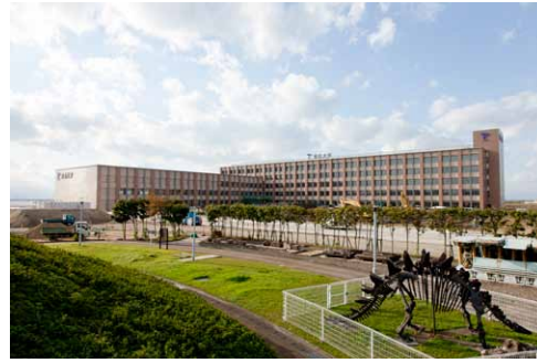
現在建設中の新福岡キャンパス
